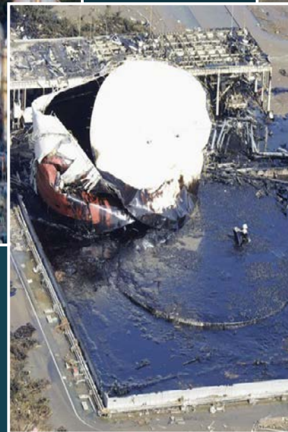
損じたガソリンスタンドの地下タンクから、是こ 式のポンプで灯油やガソリンをくみ上げる作業場 ら=20日午前9時30分ごろ、宮城県南三陸町
